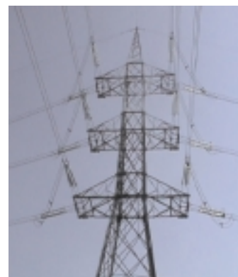
Figura 3 – Linea ad altissima tensione a doppia terna
