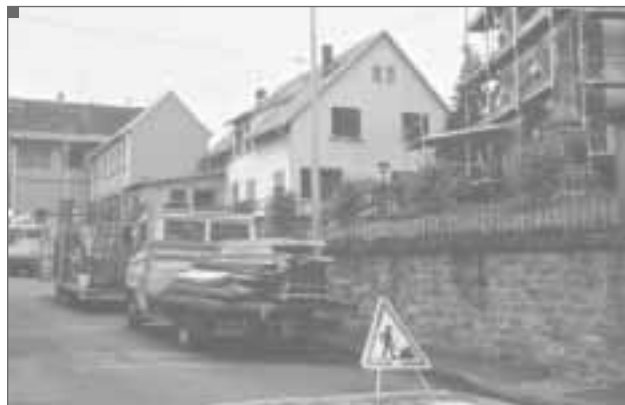
INSTALLAZIONE DEL PONTEGGIO IN PROSSIMITÀ DI UNA LINEA ELETTRICA
